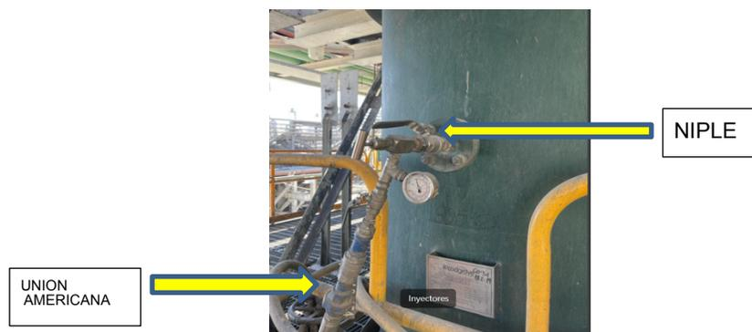
Una vez finalizado en paso anterior se debe reemplazar inyector o limpiar según su
